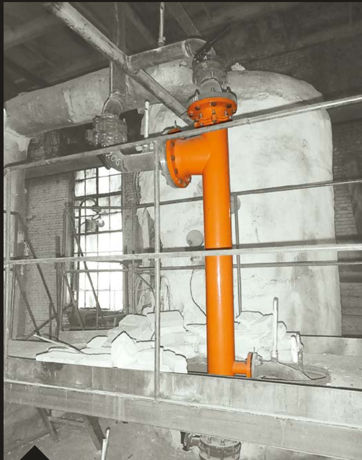
«БАЗ СУАЛ» Сентябрь 2016 г. Краснотурьинск Охладитель выпара Вес: 37 кг Вода/пар
